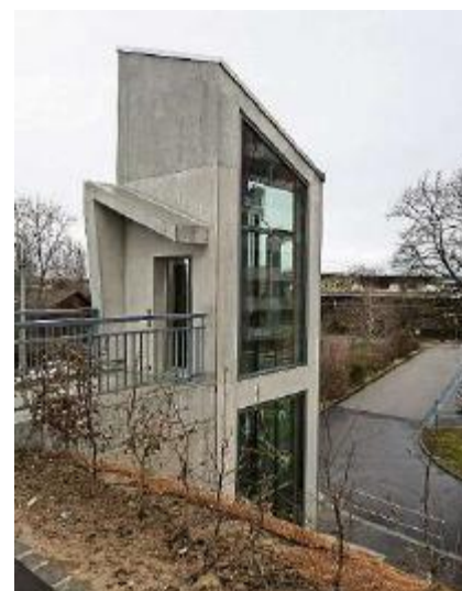
Wichtig für Gehbehinderte. Seit August 2017 stand dieser Lift für knapp 100 000 Franken mehrmals still. Foto mar
